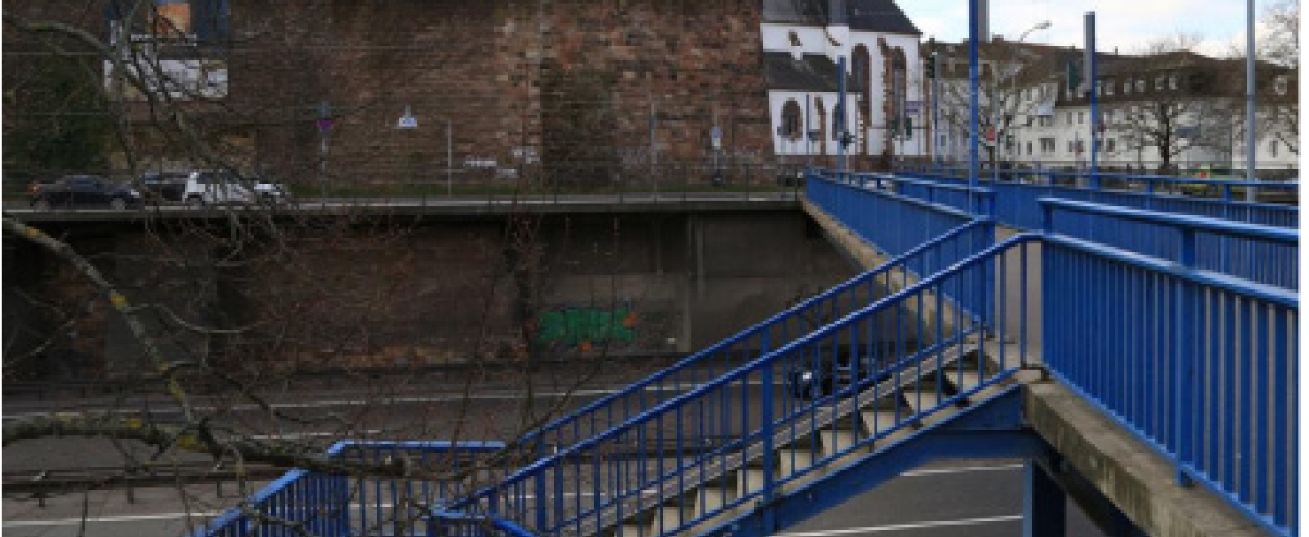
Fußgänger Verbindung an der Alten Brücke, Alt-Saarbrücken. Blick zur Schlosskirche über Franz-Josef-Röder-Straße / A620.
