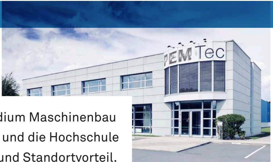
Abbildung 2: Firmengebäude der PEMTec SNC in Forbach, Frankreich
