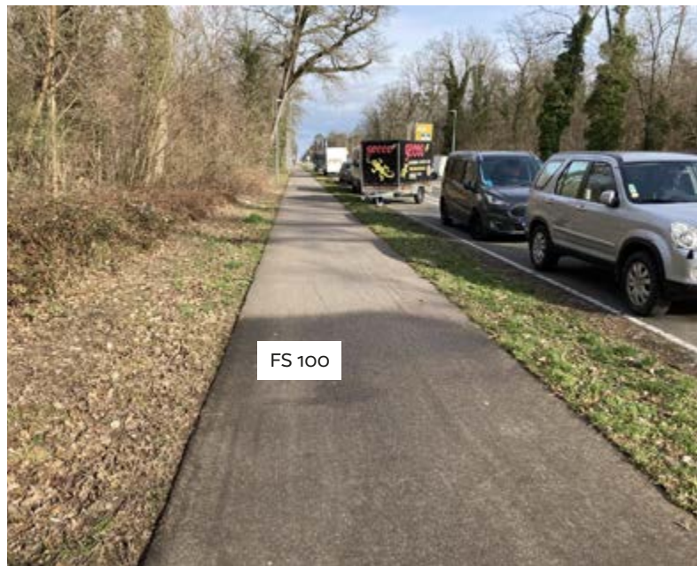
Abb. 6: Betreuter Streckenabschnitt mit FS 100 (dunkler Bereich im Bildvordergrund) nach 24 Stunden in Karlsruhe.
