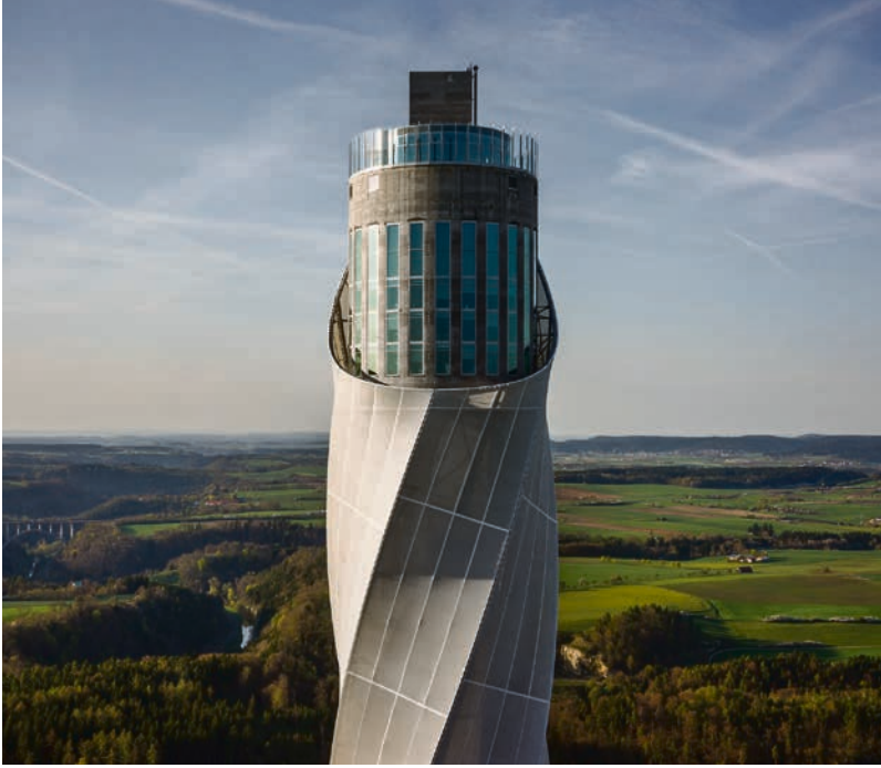
Kann durch ein Schwingungspendel im Inneren in Schwingungen versetzt werden: der thyssenkrupp Aufzugstestturm in Rottweil © thyssenkrupp Elevator
