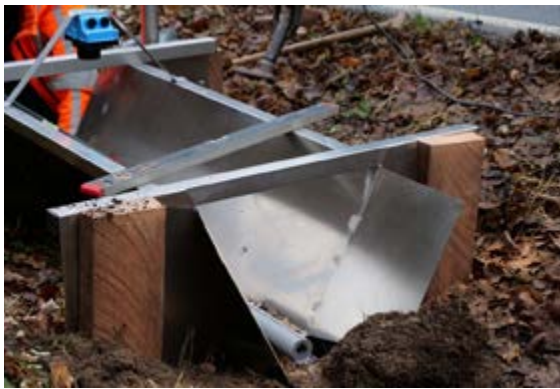
Installation einer Messrinne in Graben am Ablauf einer Agroforstfläche (Quelle: IfaS)
