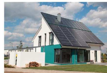
Das energieautarke Haus in Lehrte/Hannover 2011 Kombination Solarthermie und Langzeitwärmespeicher mit Photovoltaik und Akku
