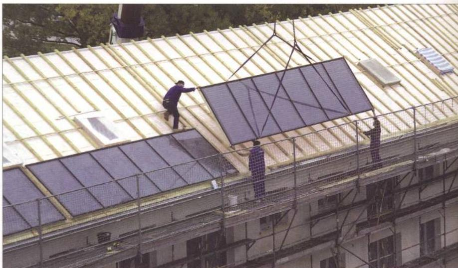
**Bild 1.** Installation des Solardaches für die Nahwärmeversorgung in Crailsheim
