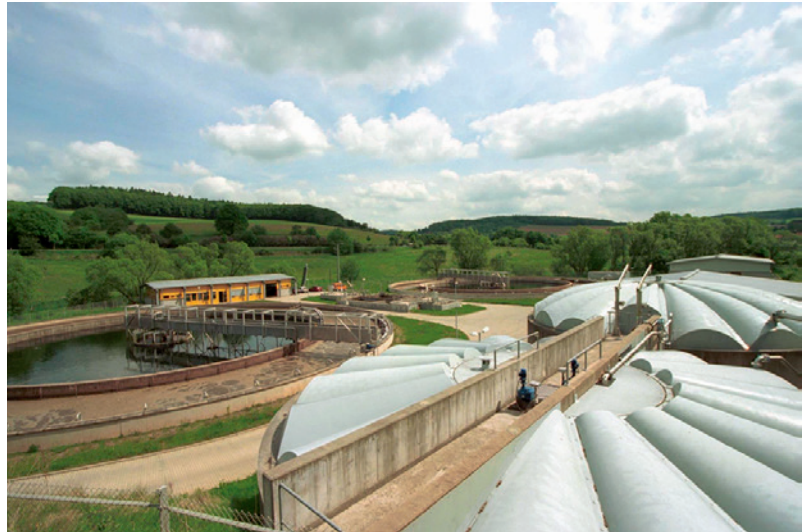
Bild 1. Biologische Reinigungsstufe der Kläranlage Wustweiler, Aufnahme vom Schlammstapelbehälter, Foto: EVS 2009 [4].
