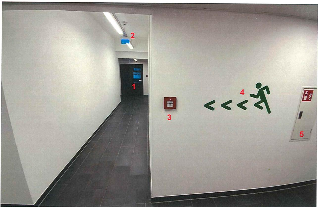
Bild: 1. Brandschutztür = Trennung eines Brandabschnitts / Fluchttür zum Sicherheitstreppenraum, 2. Beleuchtete Fluchtwegbeschilderung, 3. Handdruckmelder, 4. Laufrichtungsmarkierung, 5. Feuerlöscher
