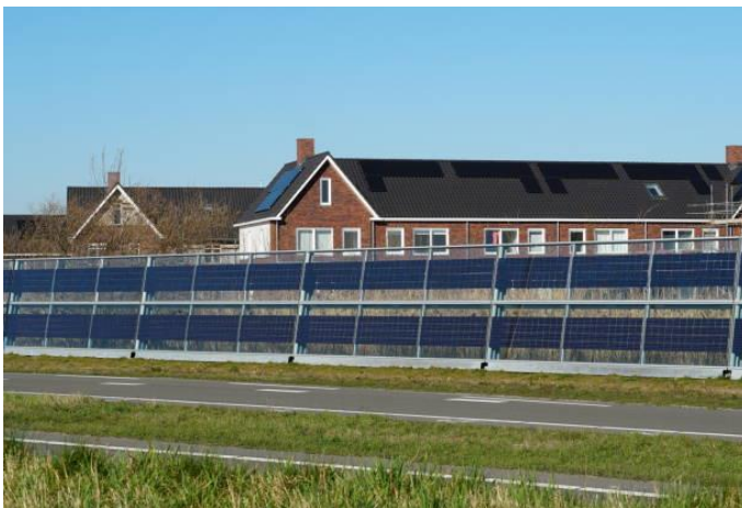
Bild 1: Lärmschutzwand mit integrierten PV-Modulen (Quelle: istock photos)
