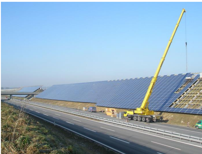
Bild 2: PV-Lärmschutzwall an der A 94 bei Töging (Quelle: Creative Commons, Nicole Grandl)
